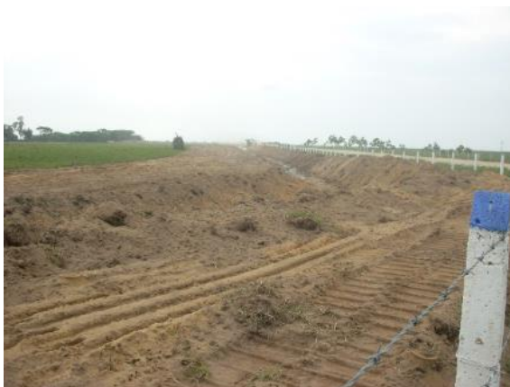
Construcción de drenajes en predios ganaderos
